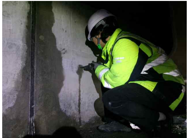
탄산화깊이 측정 현황
