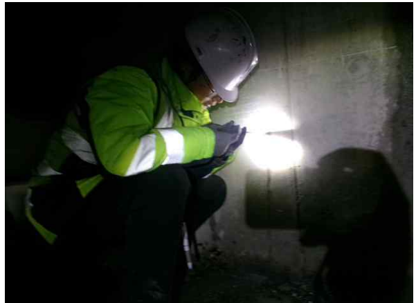
탄산화깊이 측정 현황
